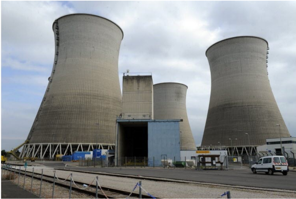
La centrale du Bugey à Saint-Vulbas, dans l'Ain. Photo Laurent THEVENOT
